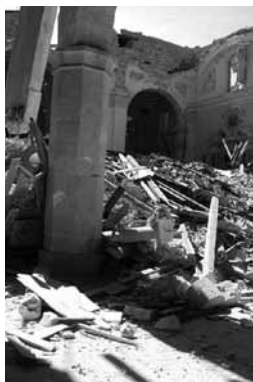
Fig. 7. Immagine del crollo dovuto al sisma.
