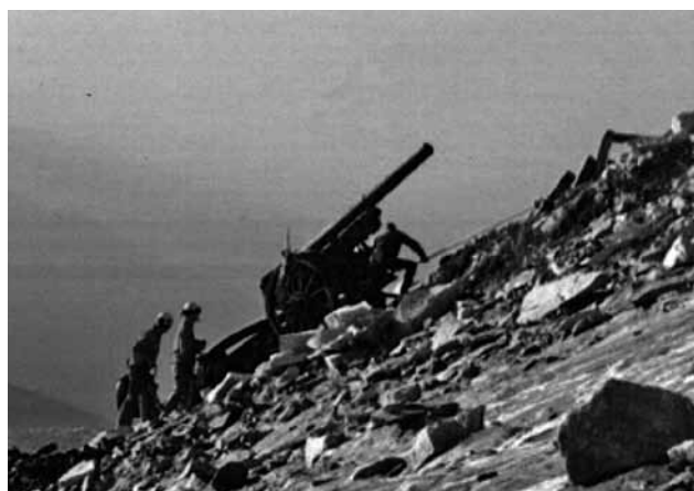
Fig. 12. Fase dell'imbragatura del cannone SKODA 10.4, modello 1915 per il sollevamento e trasporto con elicottero.
