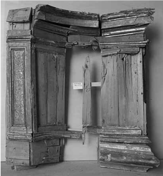
Fig. 11. Parte della sezione dx della cantoria una volta rimossi i frammenti dei pannelli scolpiti.
